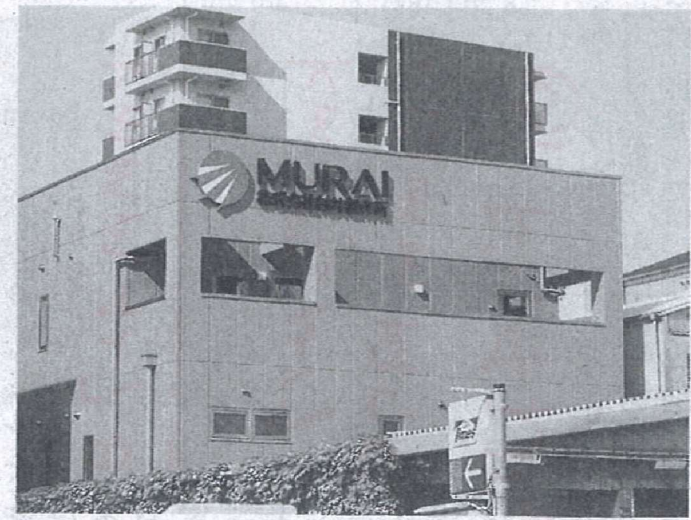
大通りから確認できる新社屋外観
